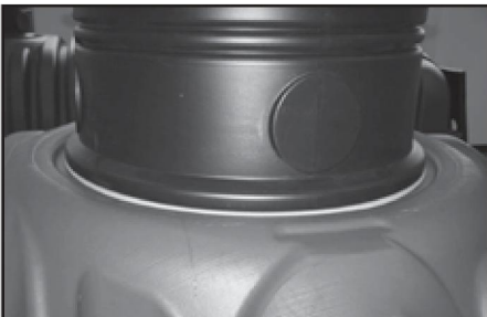
FIG.4 Install Riser
